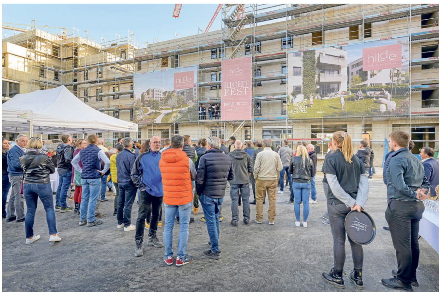
Nach einem knappen Jahr Bauzeit hat die Projektgemeinschaft „Hilde“ in der Hilde-Domin-Strasse auf dem Gelände des ehemaligen US-Hospitals in Rohrbach Richtfest gefeiert. Anfang 2026 sollen die ersten Bewohner einziehen. Foto: Philipp Rothe
