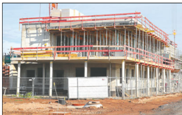
Für das neue Vereinsheim des FV Brühl stand jetzt das Richtfest auf dem Programm. Foto: Lenhardt
