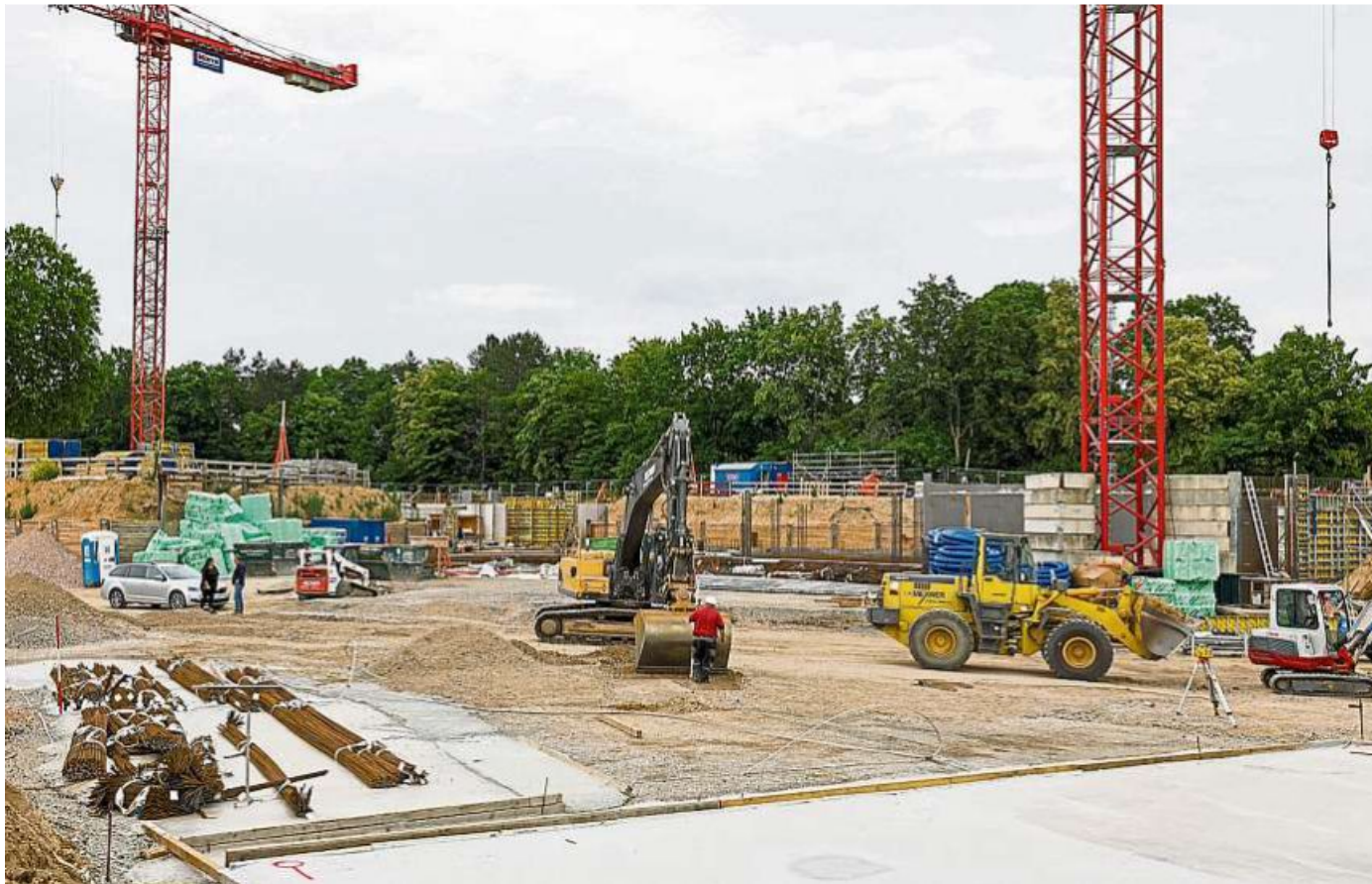
Noch sind auf der rund 34.000 Quadratmeter großen Fläche die Tiefbauarbeiten im Gange. Entstehen werden hier neun viergeschossige Gebäude und eine Kindertagesstätte. Foto: Harald Kaster
